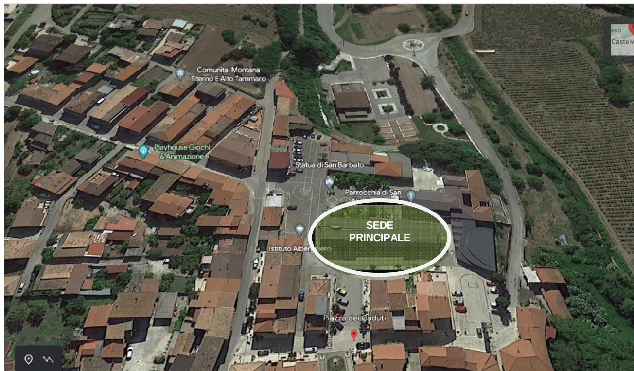
Figura 2. Sede scolastica oggetto di intervento ubicata in via Piazza dei Caduti nel Comune di Castelvenero (BN) (fotogrammetria tratta da Google Earth).
